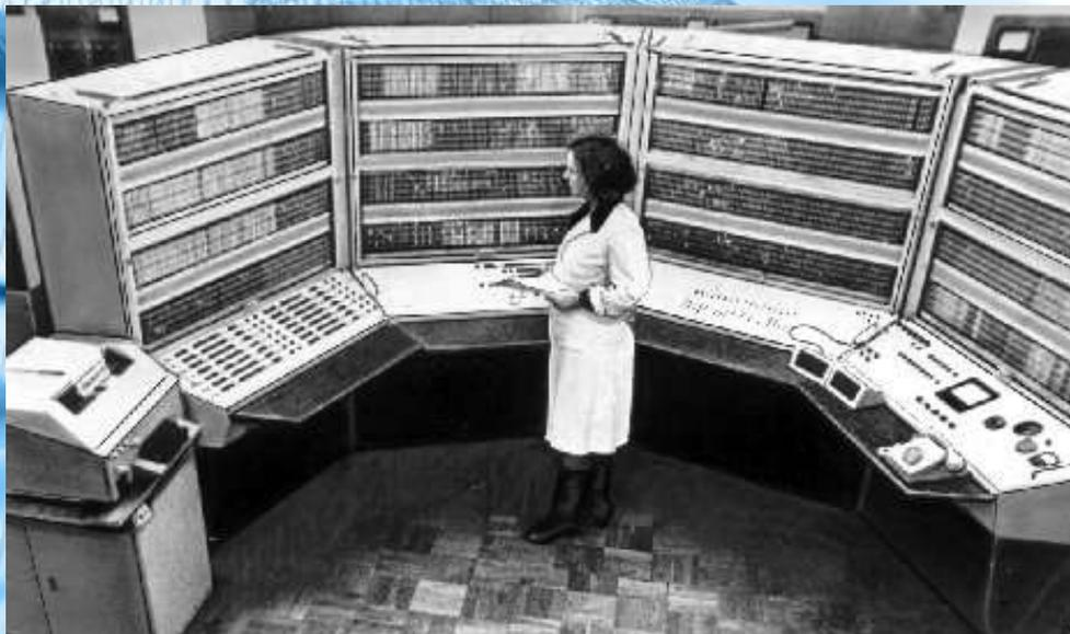
Эти дискретные транзисторные логические элементы со временем вытеснили электронные лампы. В качестве носителей информации использовались магнитные ленты ("БЭСМ-6", "Минск-2", "Урал-14") и магнитные сердечники, появились высокопроизводительные устройства для работы с магнитными лентами, магнитные барабаны и первые магнитные диски.
